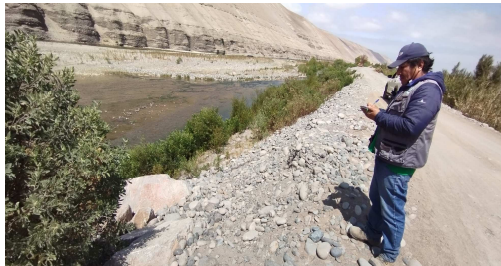
tramo de dique sin proteccion con enrocado
